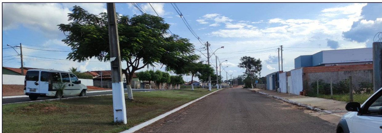
Figura 57 - Rua Um com o recapeamento recebido em microrrevestimento.
