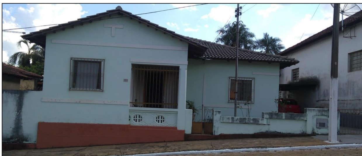
Figura 42 – Edificação ao lado da Casa União.
