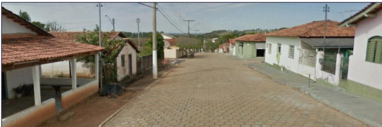
Figura 59 – Rua Goiandira, pavimentação poliédrica.
