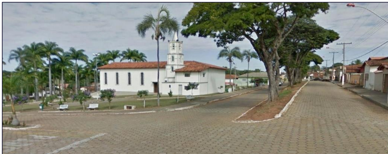
Figura 56 - Rua Boa Vista, demonstrando a pavimentação poliédrica (Bloquetes).
